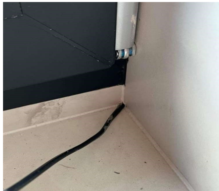
Joonis 5: Nutikile kahesooneline kaabel on toodud akna nurka
